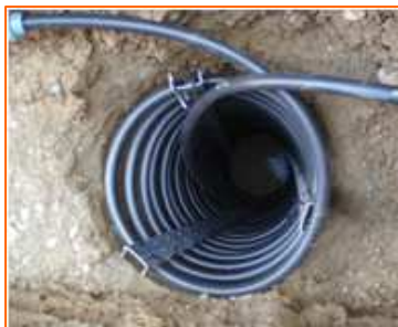
Фото 5. Коллектор в земле
