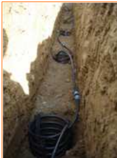
Фото 6. Коллекторы в траншее
