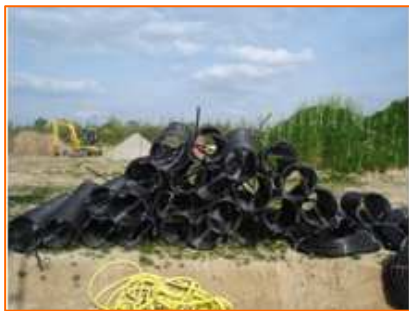
Фото 4. Коллекторы перед закапыванием
