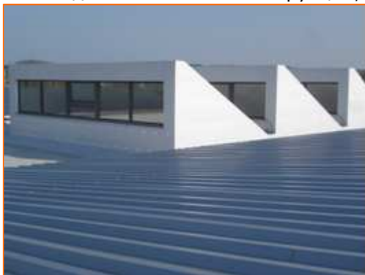
Фото 2. Шедовая крыша актового зала
